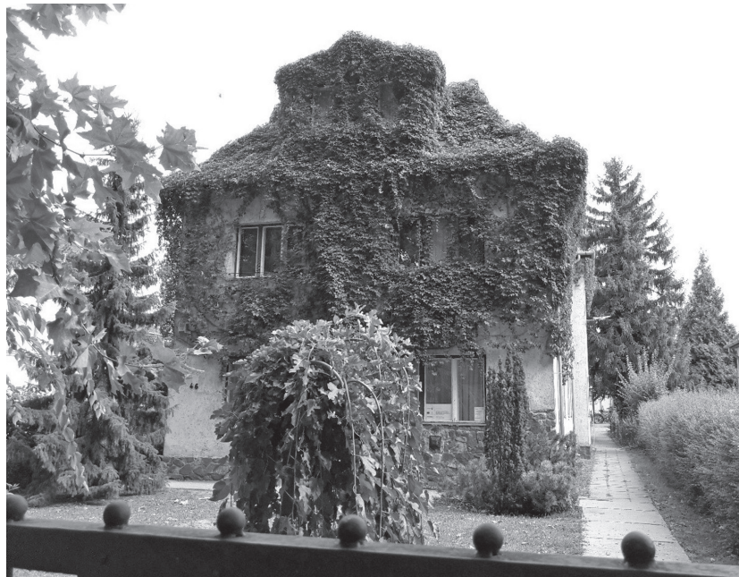
Az épület a felújítás előtt (Forrás: BRTK Könyvtár)
